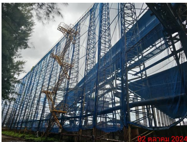
รูปที่ 6 แนวตาข่ายป้องกันฝุ่นละออง
