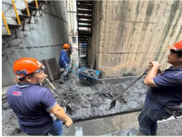
รูปที่ 22 การขุดลอกกระบระบายน้ำ
