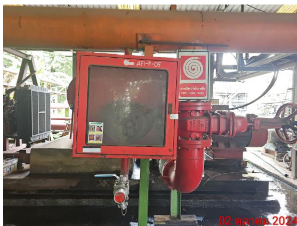
หัวจ่ายน้ำดับเพลิงและสายฉีดน้ำดับเพลิง
