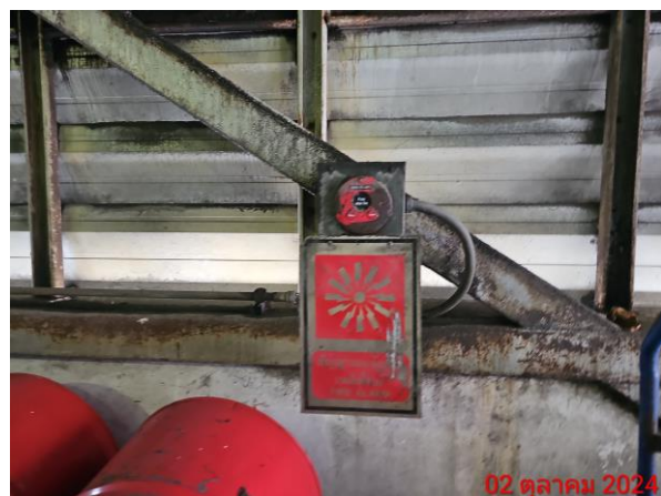
สัญญาณเสียงแจ้งเตือนเหตุไฟไหม้ (Alarm bell)
