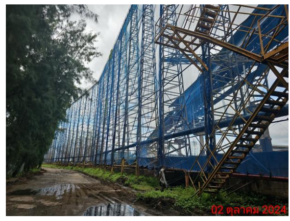
รูปที่ 6 แนวตาข่ายป้องกันฝุ่นละออง
